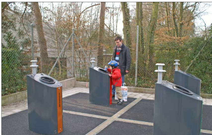
Die neue unterirdische Sammelstelle kann auch von Kindern oder Menschen mit einer Behinderung bedient werden. Foto: un
